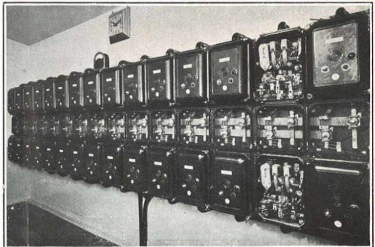
Tableau blindé de contacteurs-disjoncteurs d'un grand atelier d'emboutissage.
