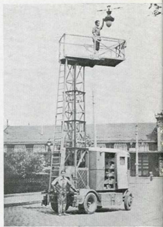
Fig. 4. — Camion avec plateforme télescopique pour l'entretien des appareils d'éclairage public. Ville de Saint-Etienne.
