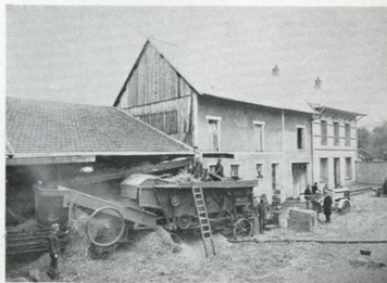
Fig. 3. — Scène de battage. Entreprise Martin. Vue prise à Verneuil-sur-Marne (Marne). Batteuse de 250 quintaux par jour avec trieur et presse, moteur 25 ch. Au fond de la cour, le tracteur à huile lourde qui assure désormais le transport sur route du matériel.
