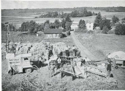
Fig. 1. — L'entreprise Quénot. Scène prise à la Cliquotte par Cuckey (Marne). Transformateur 15/24 kVA; moteur 20 ch; batteuse de 100 quintaux par jour; presse à moyenne densité et ficelage automatique par fil de fer.
