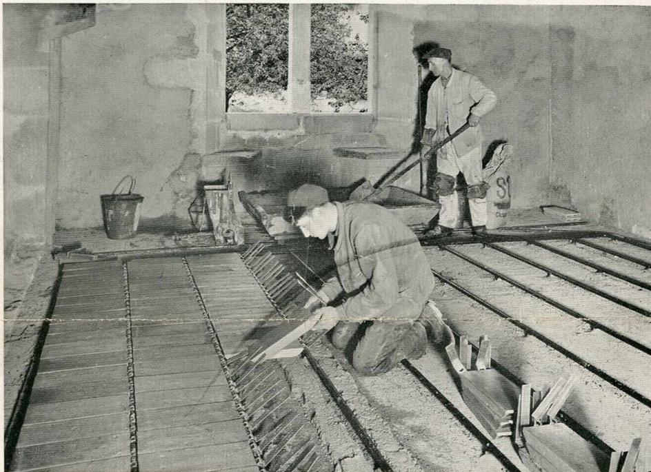
Sol chauffant en cours de Construction, pour recevoir un revêtement en carreaux.
