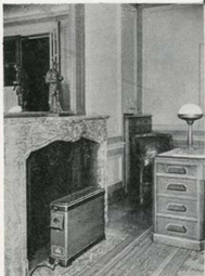
Au dessous : Chauffage total par radiateur à semi-accumulation.
