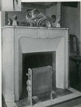
A droite : Chauffage d'appoint par radiateur direct obscur.
