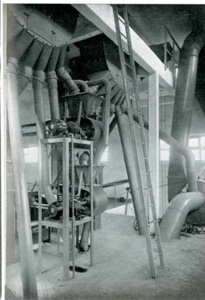
Fig. 7. — Silo de Coligny. Le double jeu de distributeurs à "pendules" et les moteurs attaquant les deux tapis roulants.
