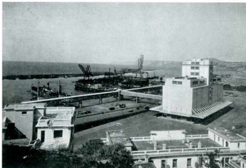
Fig. 1, en haut. — Le silo de Coligny (Marne), de la Coopérative de Champagne. Capacité : 30 000 quintaux. Fig. 2, au milieu. — La Manouba (près Tunis). Le premier grand silo équipé en vue de la sélection des blés selon leurs qualités boulangères (200 000 quintaux). Fig. 3, en bas. — Oran. Silo de 300 000 quintaux.
