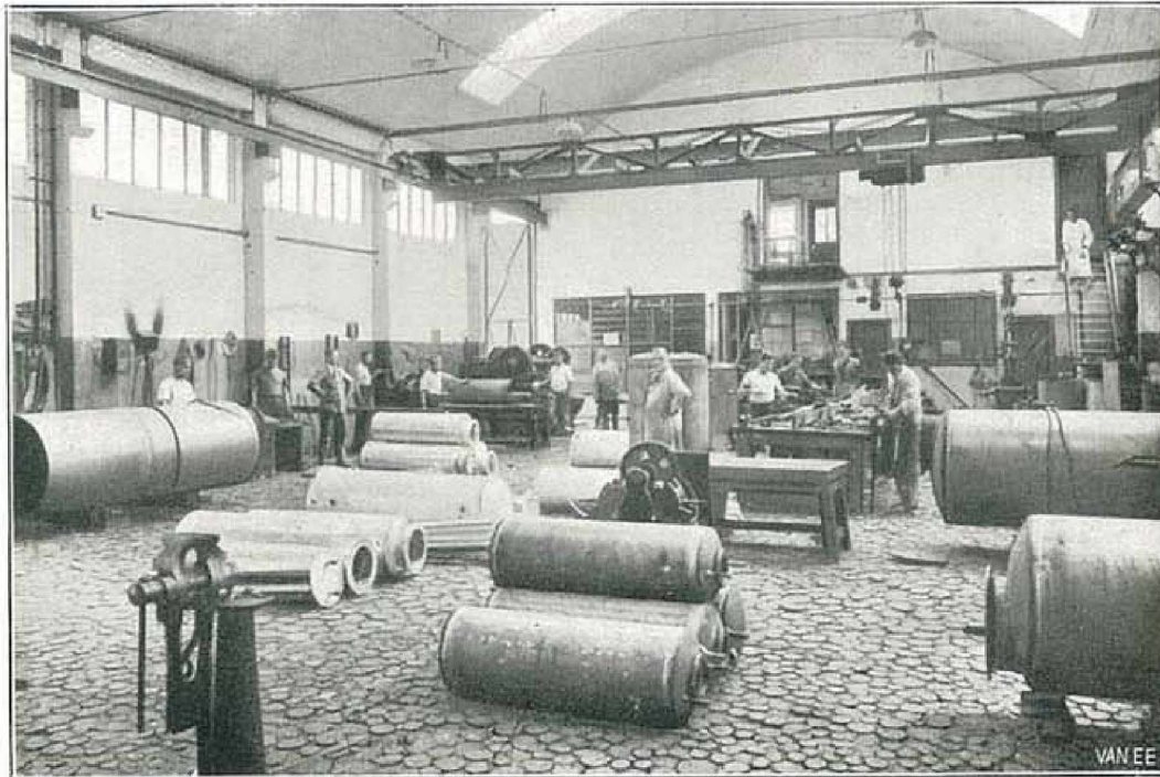
Vue d'une partie de l'atelier de soudure
