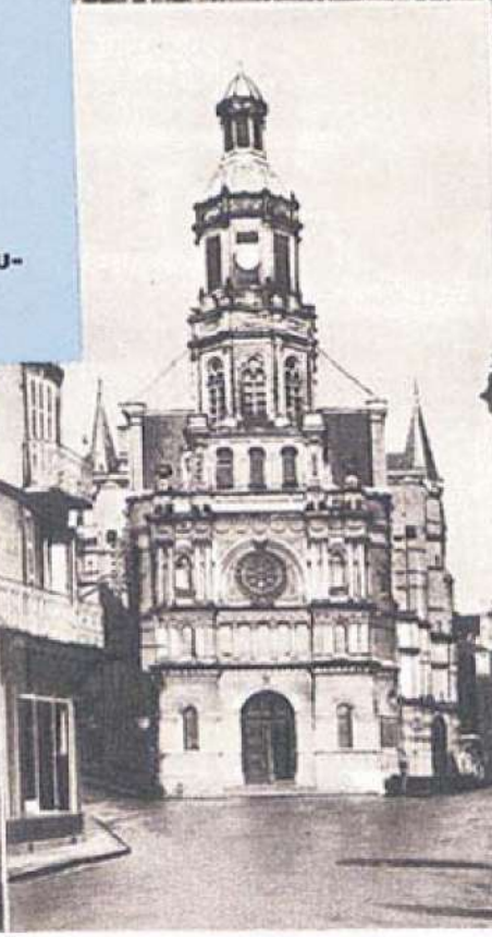
Église Notre-Dame de Bon Secours, à Trouville Puissance installée : 150.000 calories/heure.
