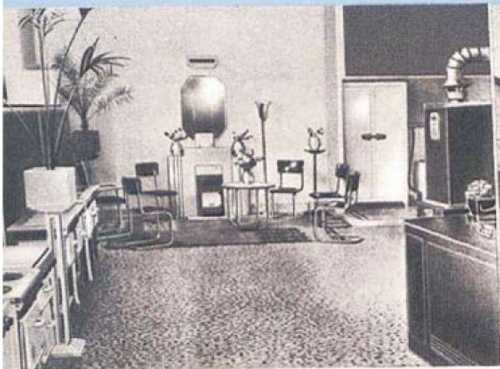
Magasin de la Compagnie du Gaz, à Chateaudun (Eure-et-Loir). Puissance installée : 20.000 calories/heure.
