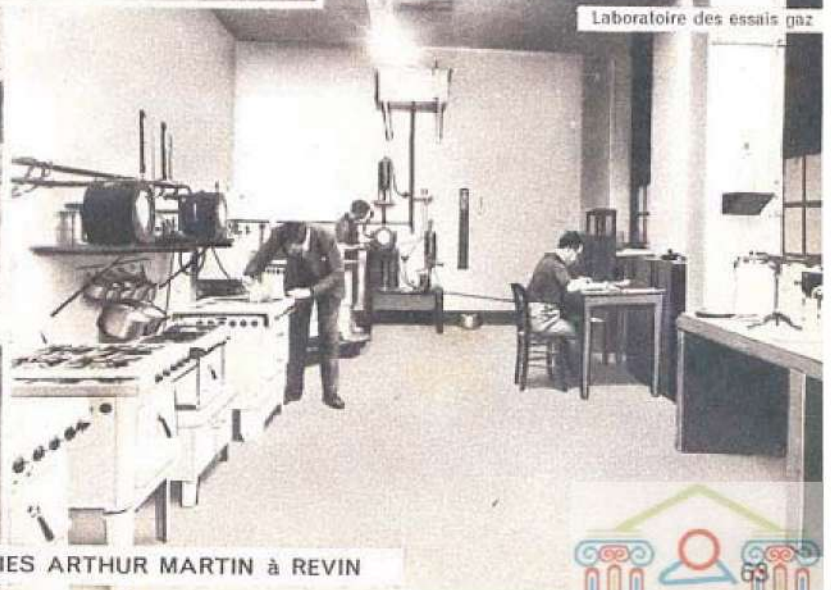
Laboratoire des essais gaz
