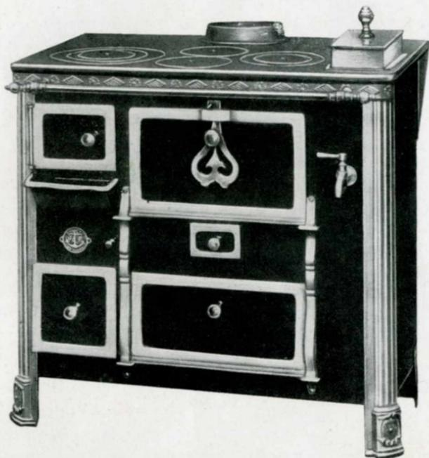
Façade en tôle ou feuillard. Angles ACIER LAMINÉ, modèle déposé. FOYER MIXTE bois et charbon
