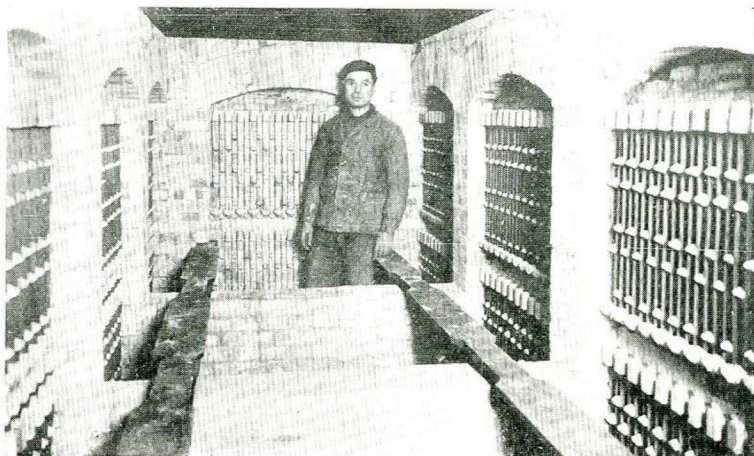
b, Vue intérieure d'un four à bain de sels en construction
