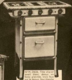
N° M. 2526. Tôle d'acier émail blanc, dessus en fonte grainée, trois foyers sur le dessus, four étanche à grande capacité et grand rendement, robotomie bakélite avec dispositif de sécurité sur le robinet four. Largeur dessus 0,495, Profondeur 0,375, Hauteur totale 0,800. Largeur utile du four 0,330. Profondeur utile du four 0,315. Hauteur utile du four 0,245. Largeur utile de la grille 0,330. Profondeur utile grille 0,315. Hauteur utile de la grille 0,155..... **895.»**
