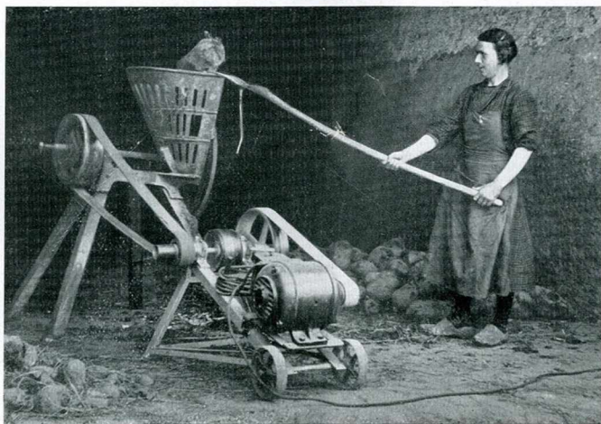
Fig. 4. - Brouette de 1,5 ch, actionnant un coupe-racines. On remarque que le réducteur de vitesse est utilisé.
