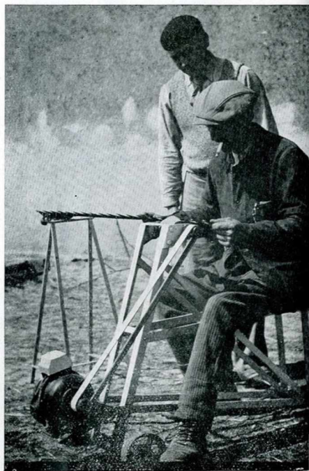
Fig. 6. - Meule à affûter les lames de faucheuse actionnée par un moteur individuel fixé au bâti.
