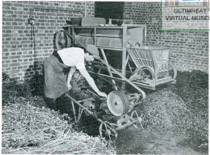
Fig. 3. - Moteur triphasé sur brouette. Réducteur de vitesse par courroies.
