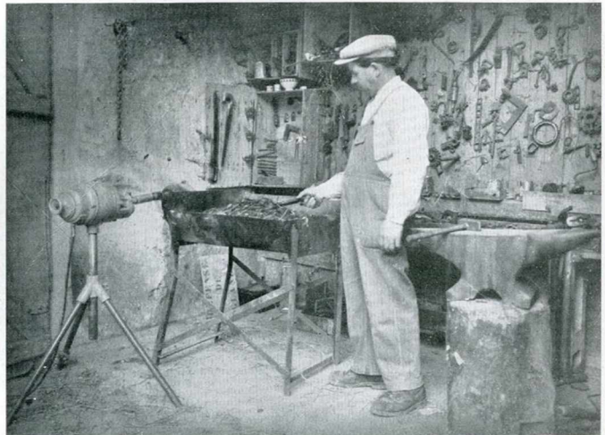
Fig. 4. - Petit moteur sur trépied, accouplement par manchon.
