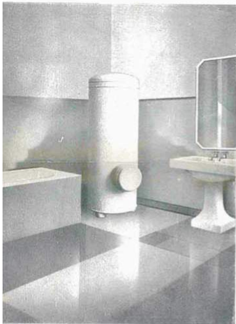
Fig. 2. - Chauffe-eau posé sur le sol. - Pour les capacités supérieures à 150 litres en 115 volts et à 300 litres en 230 volts, le thermostat doit commander un contacteur placé à proximité du chauffe-eau.
