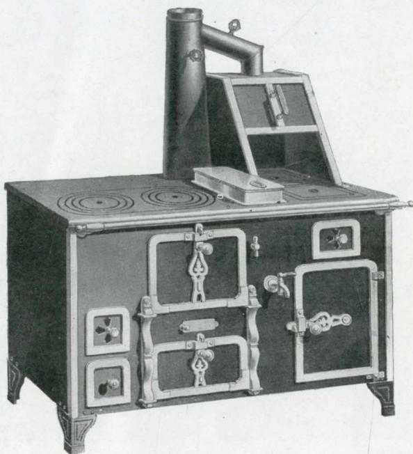
Un four à retour de flamme. Garde-rôtis. Foyer **charbon** ou foyer **bois et charbon** avec porte en façade. A **charbonnier** ou à **étuve**, avec un seul cendrier. Avec ou sans chaudière. 1 mitre à clé. Grillade à droite ou à gauche. 2 réchauds. 1 chauffe-assiettes.
