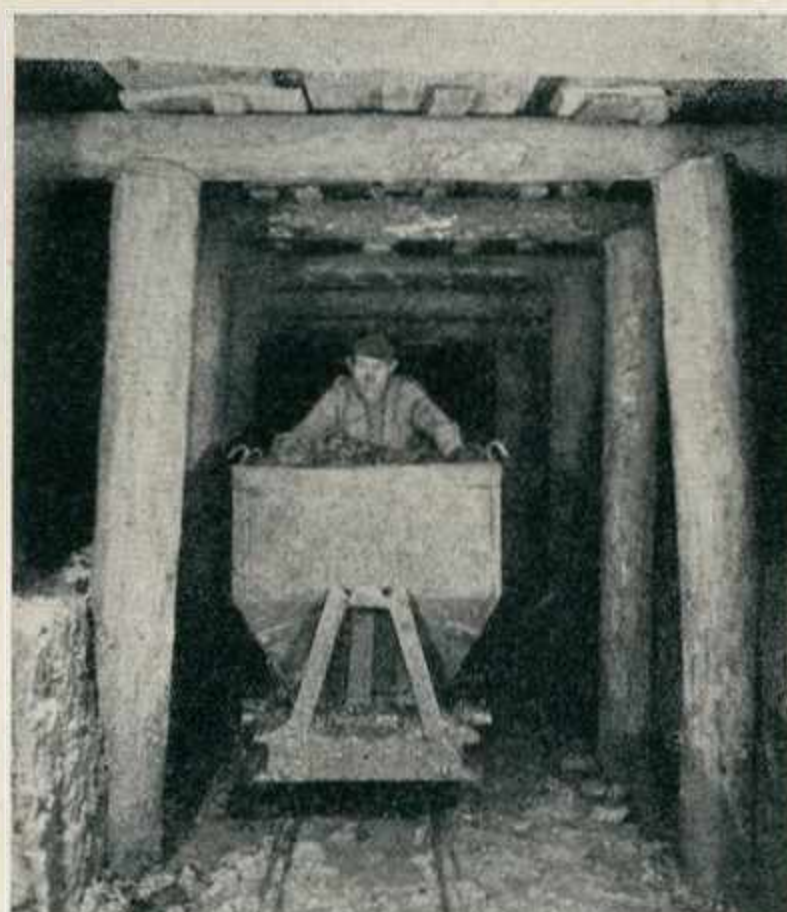
Transport des wagonnets chargés vers le treuil du puits.
