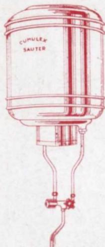
Eprouvés à 15 kilogs, fabriqués selon les mêmes procédés que les " CUMULUS ", les " CUMULEX SAUTER " 14 et 25 litres, de faible encombrement et de rendement élevé se recommandent pour l'alimentation en eau chaude des éviers, lavabos, salons de coiffure, cabinets médicaux, etc...
