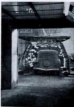
Fig. 21. — Etuve-cloche (position ouverte.) Traitement de peinture sur carrosserie automobile 160 lampes.
