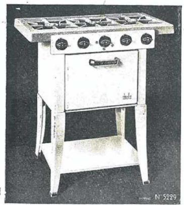
Four calorifugé, à triple circulation des gaz, maintenant dans toute la capacité du four une température égale.
