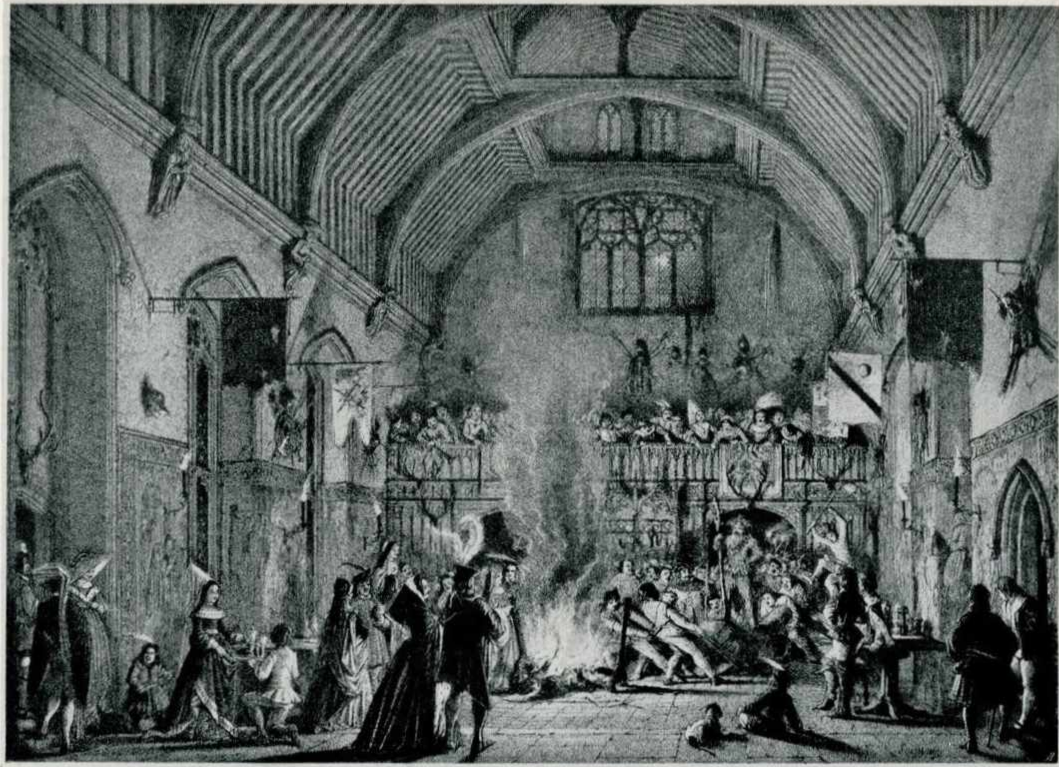
Figure 6. Le feu ouvert, seul moyen de chauffage des halls anglais, s'est conservé jusqu'au XIV e siècle. Vue du hall de Penshurst, comté de Kent. Les gaz de fumée s'échappaient au dehors par des ouvertures pratiquées dans les combles. (Texte, page 38.)
