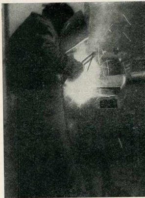
Fig. N° 8. — Soudure d'un collecteur.
