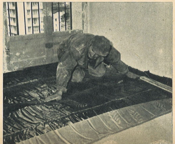
Le « feutre sol-flottant » : empêche les chocs de se transmettre et les calories de se perdre. (Thermover).
