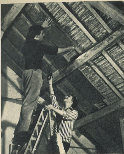
Le calorifugeage des combles peut s'exécuter à deux personnes avec une très grande facilité (Roclaine).
