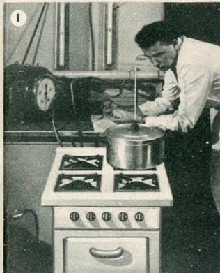
1 Un contrôleur mesure le temps nécessaire à la mise en ébullition d'une quantité d'eau déterminée.
