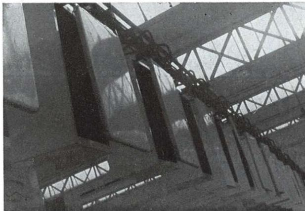
Dans l'usine de Fourmies, le recours aux convoyeurs-aériens permet de résoudre en même temps les problèmes de la manutention et ceux du stockage.
