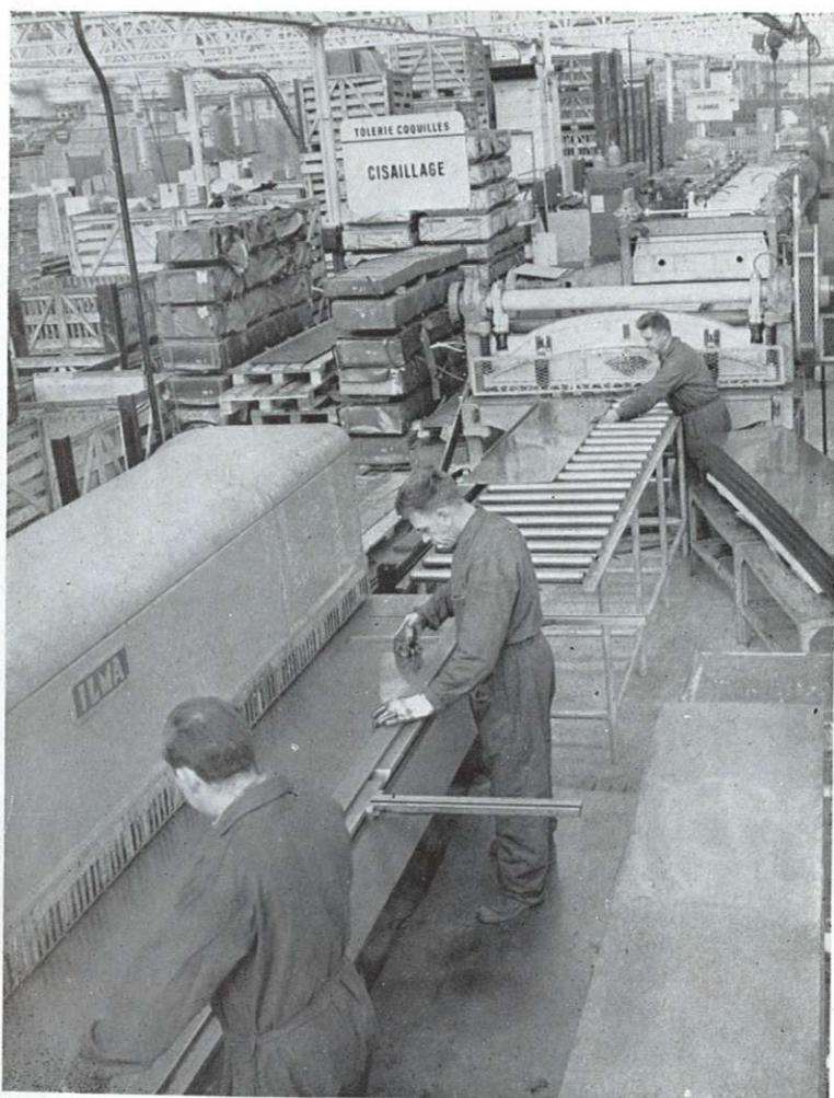
Chaîne des coquilles. Une suite de machines automatiques assure la préparation et la mise en forme des carrosseries (coquilles) des réfrigérateurs : cisailage des tôles, perçages, pliages. Servie par 8 ouvriers seulement, cette chaîne peut atteindre une cadence de 150 appareils à l'heure.
