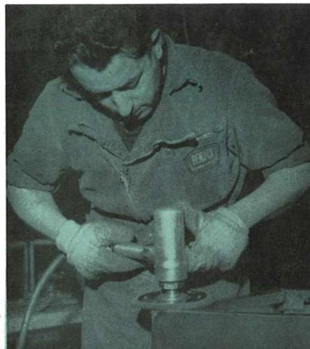
Contrôle des coquilles... et ponçage des brasures. Le recours à l'automatisme ne supprime pas, à l'échelon de la finition, l'intervention directe du professionnel. A l'extrémité de la chaîne de tôlerie, des contrôleurs-retocheurs mettent la dernière main aux coquilles avant de les livrer à la chaîne de bonderisation.
