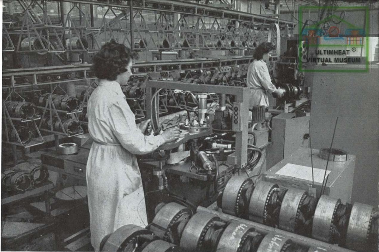
Moteurs de Fourmies. Bobinage des inducteurs. Cette machine, entièrement réalisée à l'usine, bobine un inducteur (phase principale) à la minute. Elle assure ainsi une cadence de production équivalente à celle de 10 personnes travaillant à la main.
