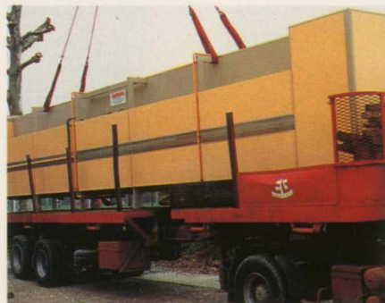
Chargement d'un tunnel pour sa livraison
