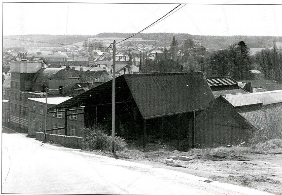
Vue prise depuis la rue de Boussu.
