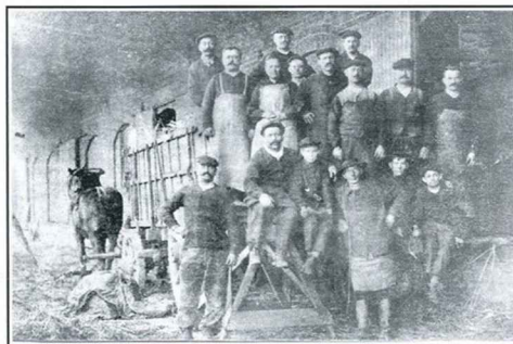
Les chevaux étaient souvent mis à contribution pour les déplacements de matériaux et d'appareils finis.
