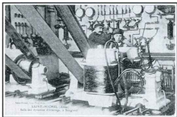
Dans la salle des dynamos, panneaux de marbre et commandes étincelantes...
