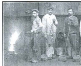
Devant le cubilot, les mouleurs attendent de remplir leur « louche » de fonte en fusion.
