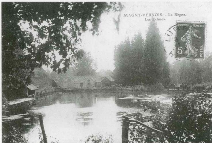
Une retenue sur La Règne formant un petit étang fournissait la force motrice aux nombreuses installations : soufflerie du haut fourneau, forge, fenderie, laminoirs et scierie.
