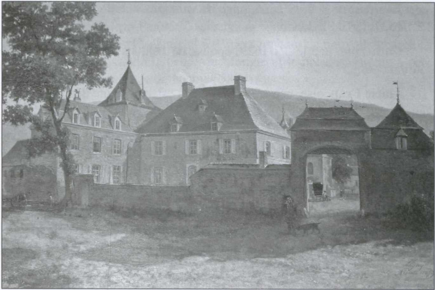
La ferme du Maugré, qui fut transformée (tableau appartenant à M lle la comtesse de Villermont).
