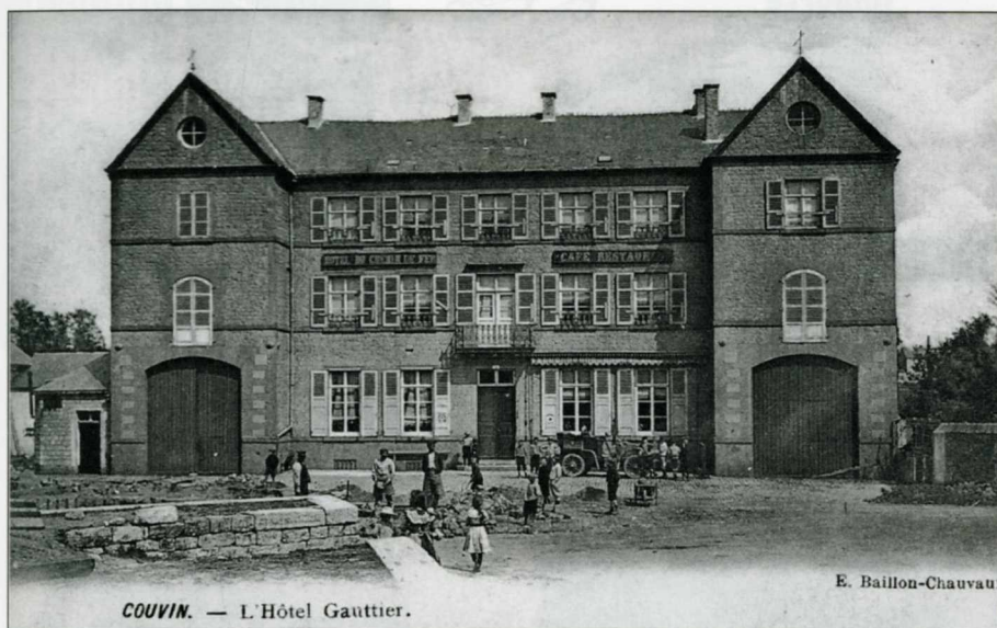
Les premiers bâtiments de l'usine, au centre de la photo
