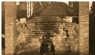
Four Dragon traditionnel chinois (龙窑 Long Yao), vue de la bouche d'alimentation et méthode de remplissage avec des porcelaines électriques (collection privée).
