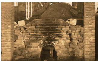
传统的中国龙窑，填充口及用电高频瓷填充的方法（私人收集）
