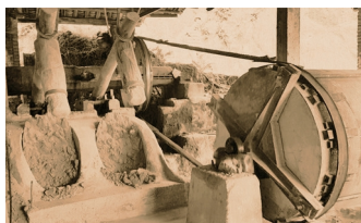
传统的生产机械（水碓），生产用于制作电高频瓷的粉末（私人收藏）
