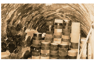
传统的中国龙窑，填充口及用电高频瓷填充的方法（私人收集）
